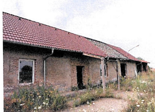
západní část domu
