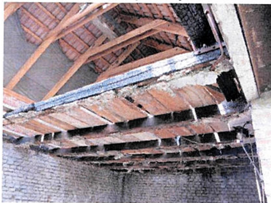
krov nad skladem
